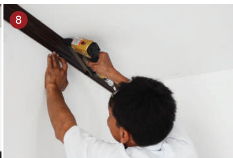
ยึดด้วยตะปูลมไว้ (ถ้าไม่ยึดด้วยตะปูลมก็จะต้อง ก่อนจะติดบัวอีกด้านหนึ่งให้ทากาวที่มุมทุกครั้ง จับเอาไว้ 4-5 นาทีเพื่อรอให้กาวพลังตะปูแห้ง)
