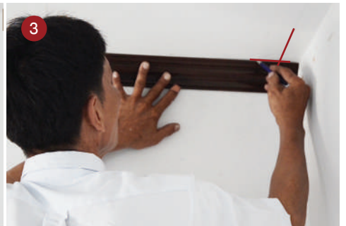
ทำเหมือนขั้นตอนที่ 2 แต่ขีดเส้นกับกำแพงอีกด้านหนึ่งเพื่อหาจุดตัด
