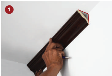
นำไม้บัวทาบกับกำแพงให้ตั้งฉาก
