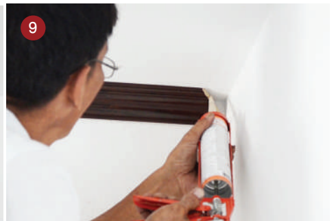
ยึดด้วยตะปูลมไว้ (ถ้าไม่ยึดด้วยตะปูลมก็จะต้อง ก่อนจะติดบัวอีกด้านหนึ่งให้ทากาวที่มุมทุกครั้ง จับเอาไว้ 4-5 นาทีเพื่อรอให้กาวพลังตะปูแห้ง)
